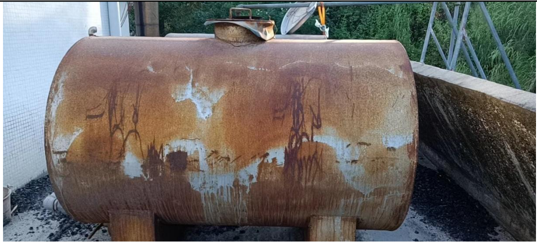
图 3.1-1 项目柴油储罐现场
